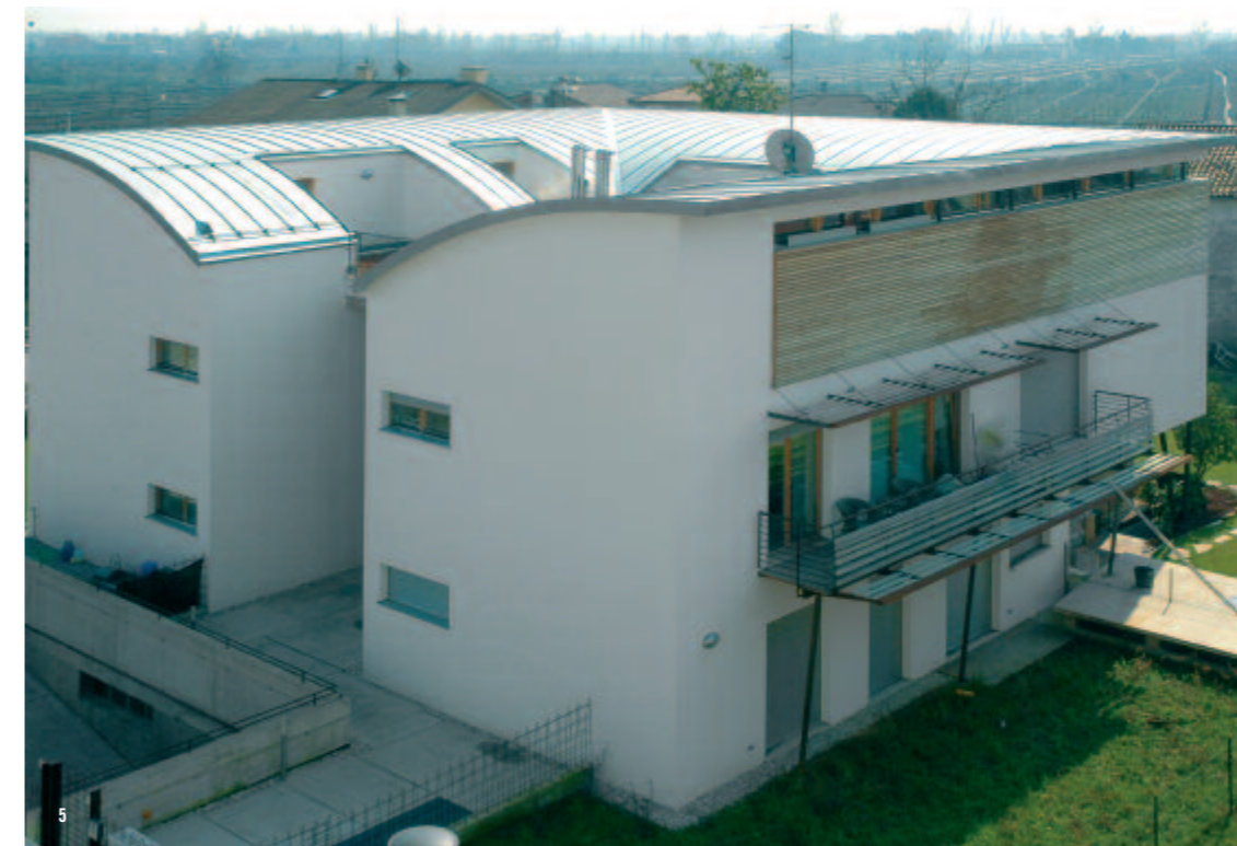
5 Il lato nord chiuso, con poche aperture, a protezione dei venti invernali
